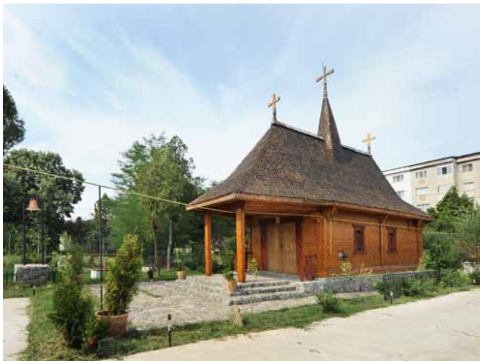
Capela „Sfântul Calinic de la Cernica” - Direcția Generală de Protecție și Asistență Socială a Copilului - Roșiorii de Vede
